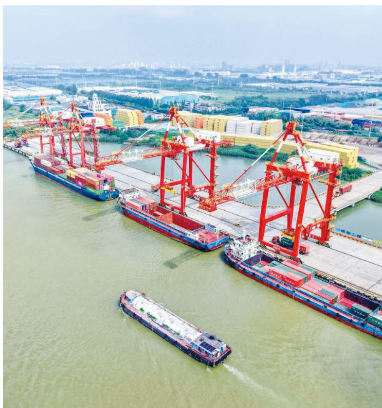
▲ 7月13日拍摄的江苏省扬州港作业场景（无人机照片）。
